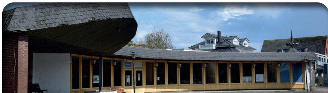
Altes Kurparkhaus Haffkrug – Abbruch steht ab September an. Wenn auch die schöne Form verlorengeht, so bekommt Haffkrug ein richtiges „Kulturhaus“. Nach Abbruch wird mit dem Neubau gleich begonnen / ab ca. Juni 2019 „wollen“ wir Haffkruger rein!
